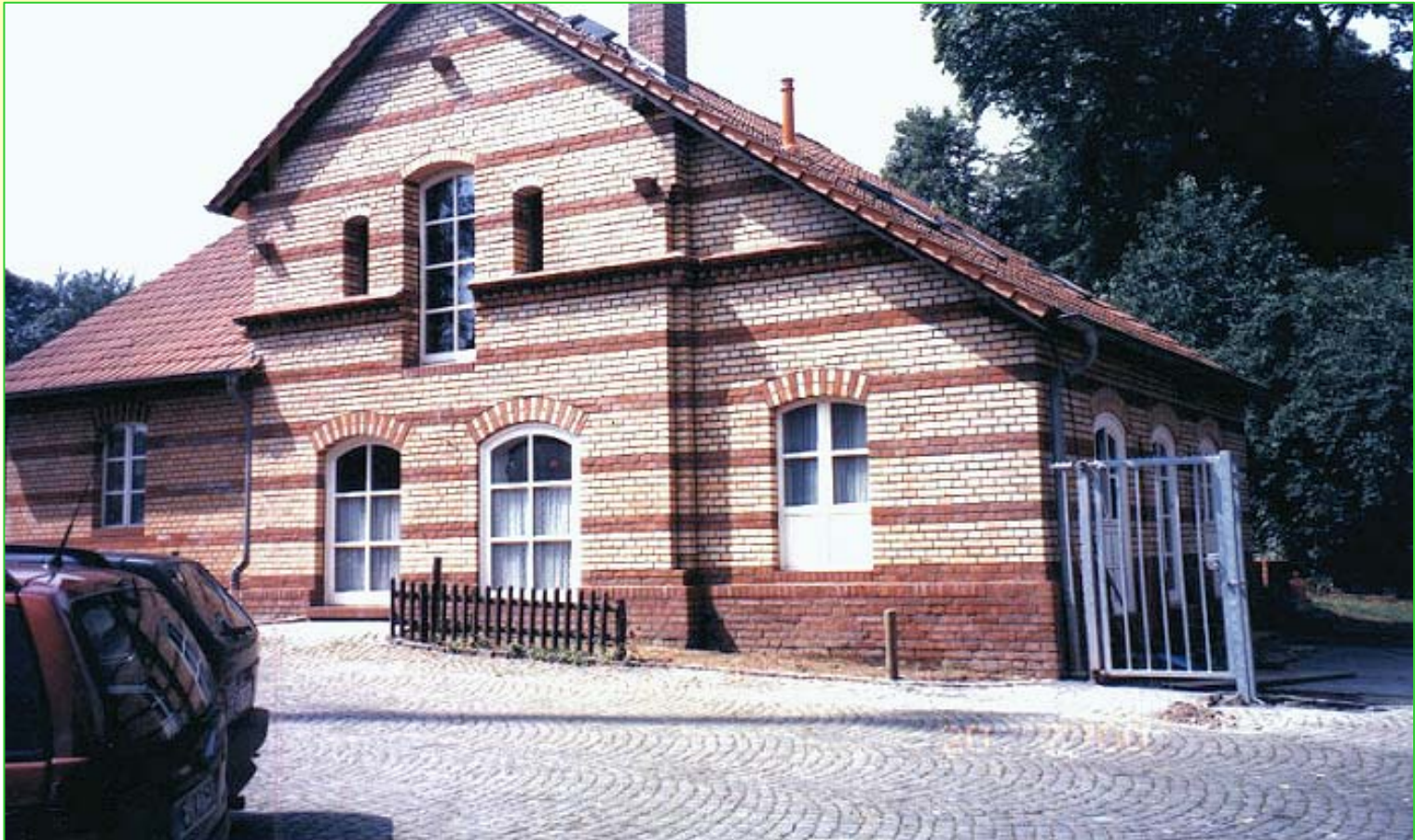
Teilansicht nach erfolgter Sanierung.
