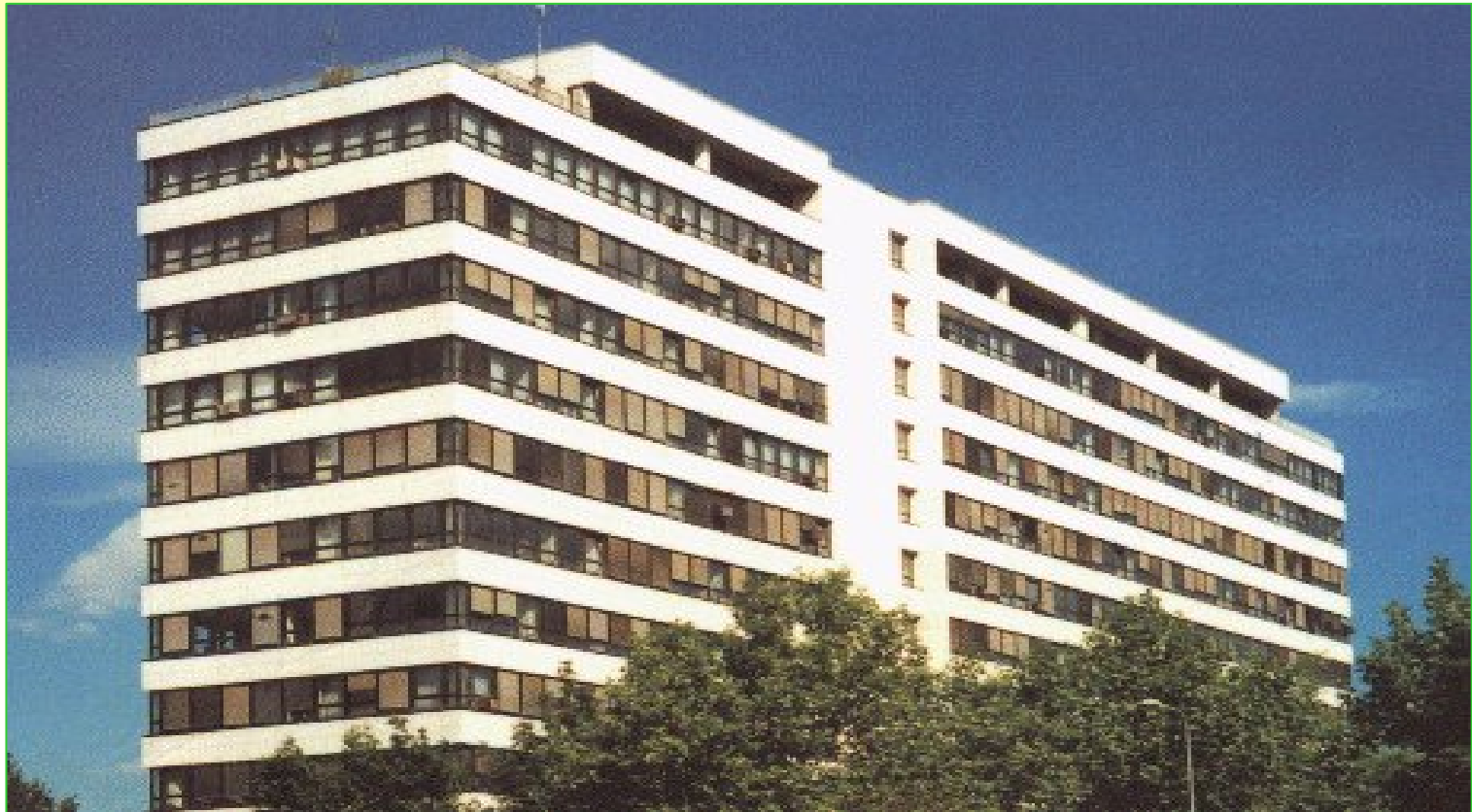
Bürogebäude in Eschborn bei Frankfurt/Main
